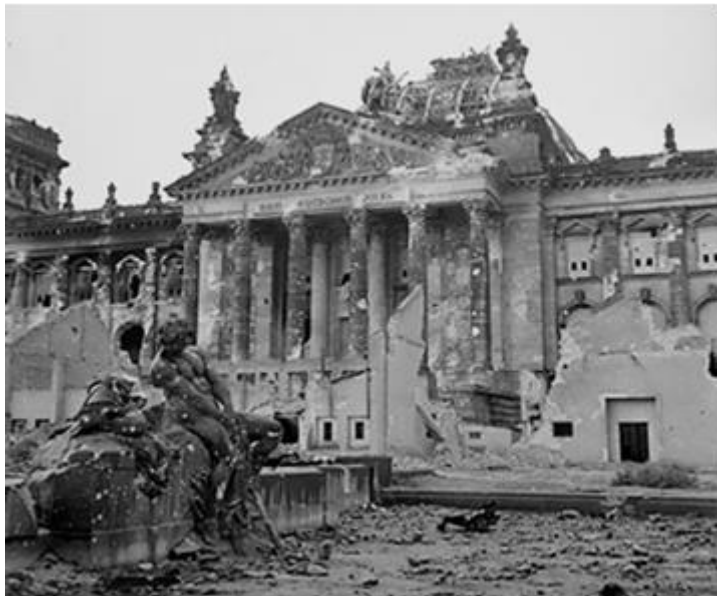
Edificio del Reichstag destruido, 1945. (Wikimedia Commons)
