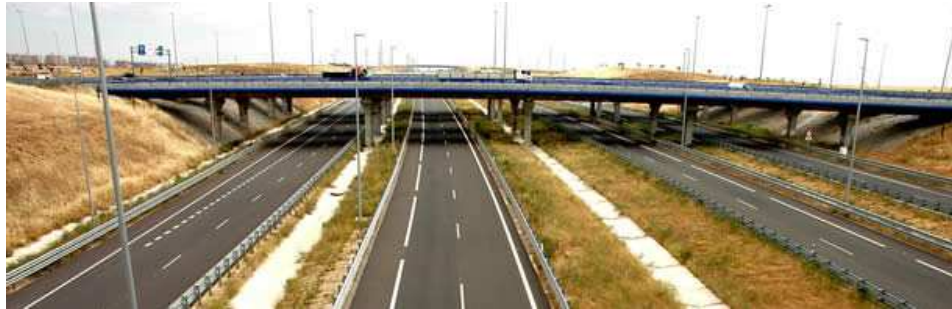
Autopista de peaje. Vía de alta capacidad
