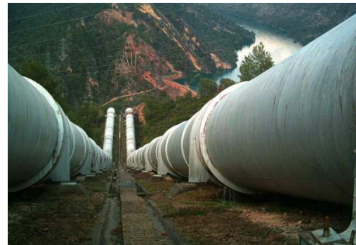
Tuberías de un trasvase
