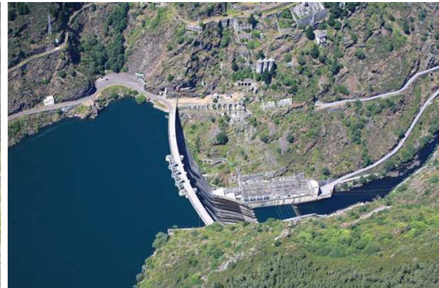
Hidroeléctrica en los saltos del Navia
