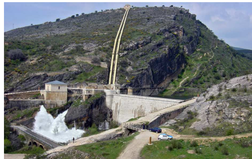
Presa del Pontón de la Oliva
