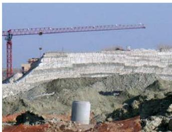
**Figura 9.55.** Fallas inversas (horst) en una excavación (cmm).
