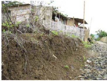
Figura 8.73. Construcción de infraviviendas sobre terrenos inestables fácilmente erosionables por las abundantes lluvias que asolan la región.
